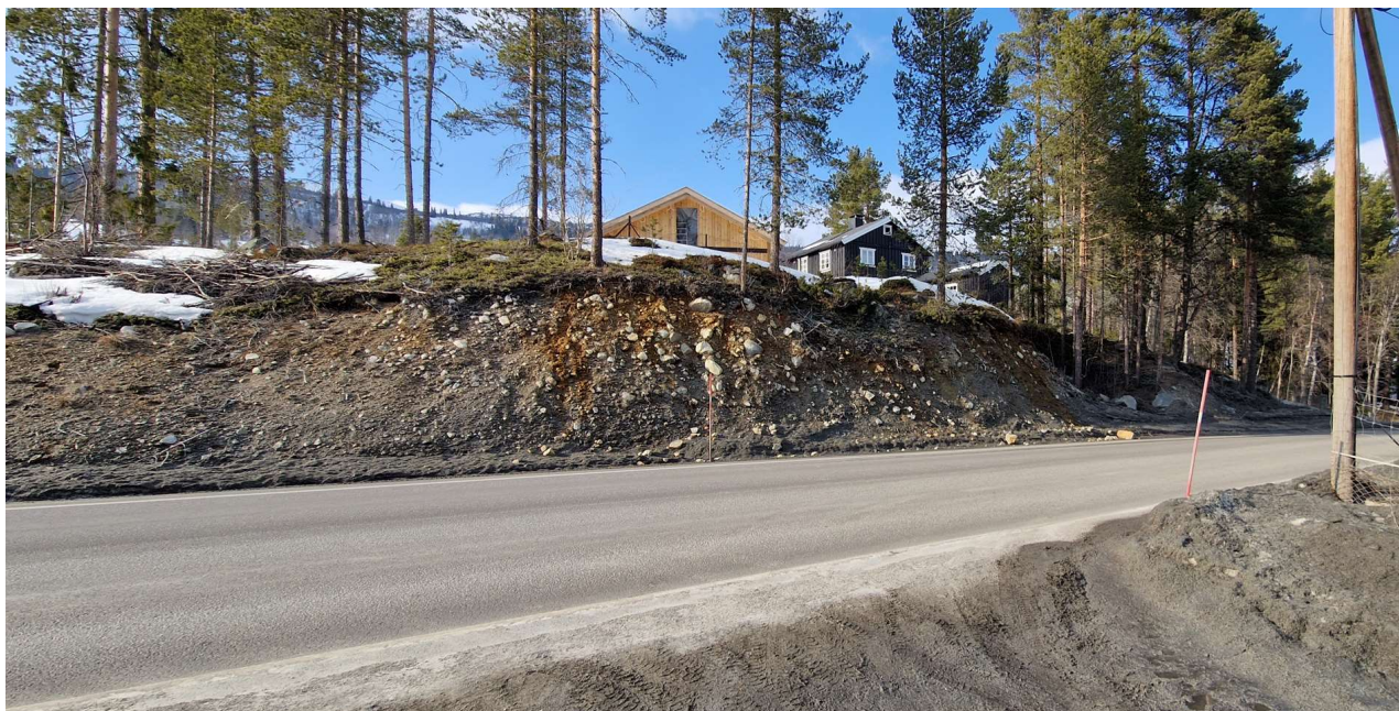
Figur 27 Viser bilde tatt 2022 av skråning mot veg ved BP 704 i området ved P3500 med eksponerte masser
